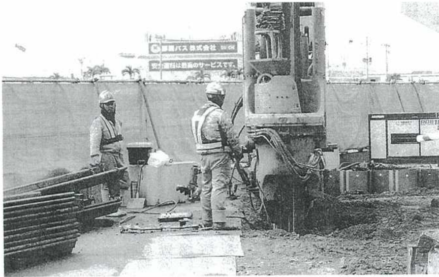
土留・仮締切作業の様子
